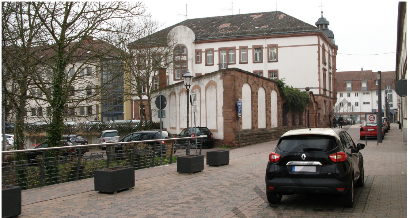
Abbildung 5: Blick von der Queichbrücke in der Bismarckstraße auf die denkmalgeschützten Bestandsgebäude, eigene Aufnahme ISU.
