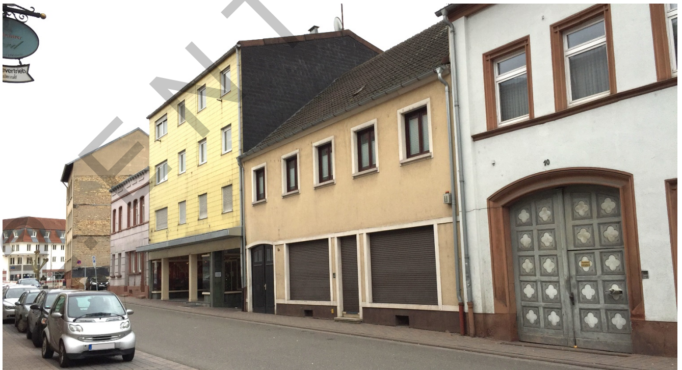
Abbildung 6: Von Leerstand betroffener Abschnitt der Hauptstraße mit Baulücke, eigene Aufnahme ISU.
